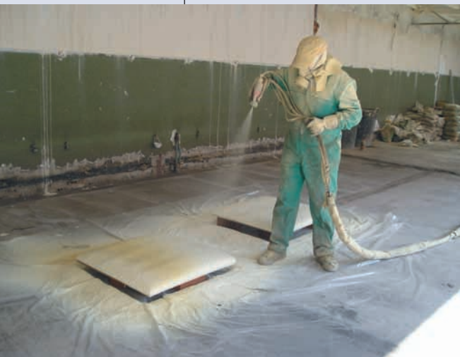
Aplicador de poliuretano in situ preparando unas probetas para ensayar la conductividad térmica en un laboratorio acreditado.
