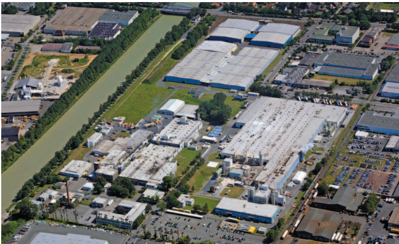
Panorámica de la sede de Armacell International GMBH (Münster, Alemania).
