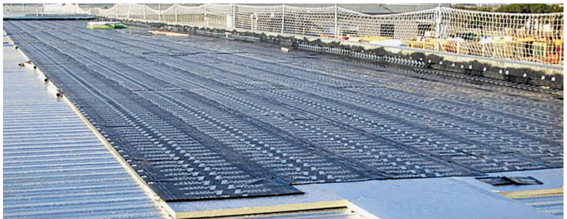
Ejecución de una cubierta con aislamiento térmico PIR con recubrimiento de aluminio gofrado.
