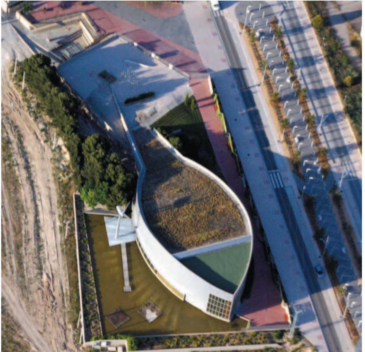
Museo de la Naturaleza y el Viento en la Muela, Zaragoza. 750 m 2 cubierta vegetal.
