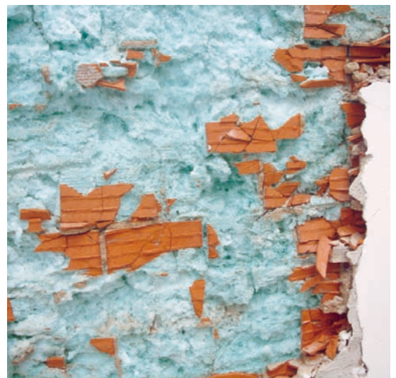
Relleno de pared con Phono Spray I 905
