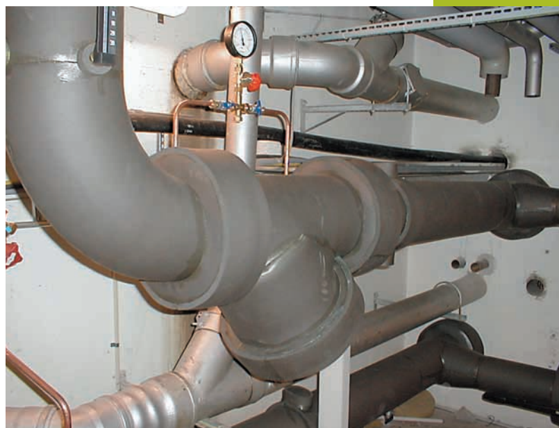
Figura 4. Fotografía de una sala de calderas de un edificio.
