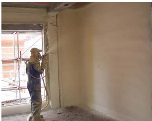
Detalle de aplicación de Proyección de espuma de Poliuretano de celda cerrada
