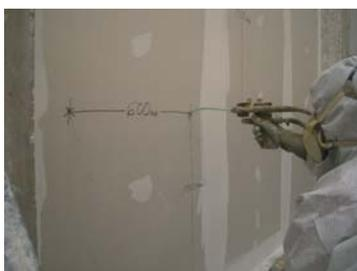
Detalle de aplicación de Proyección e Inyección de espuma de poliuretano Termoacústica
