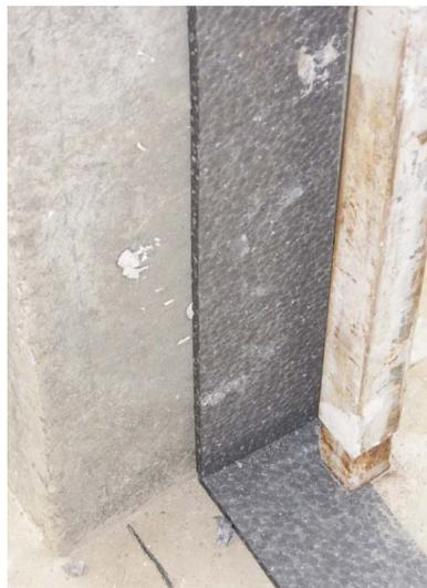
Colocación de banda de EEPS en perímetro de fábrica
