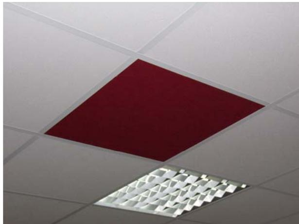
Detalle de un techo acústico con lana de poliéster
