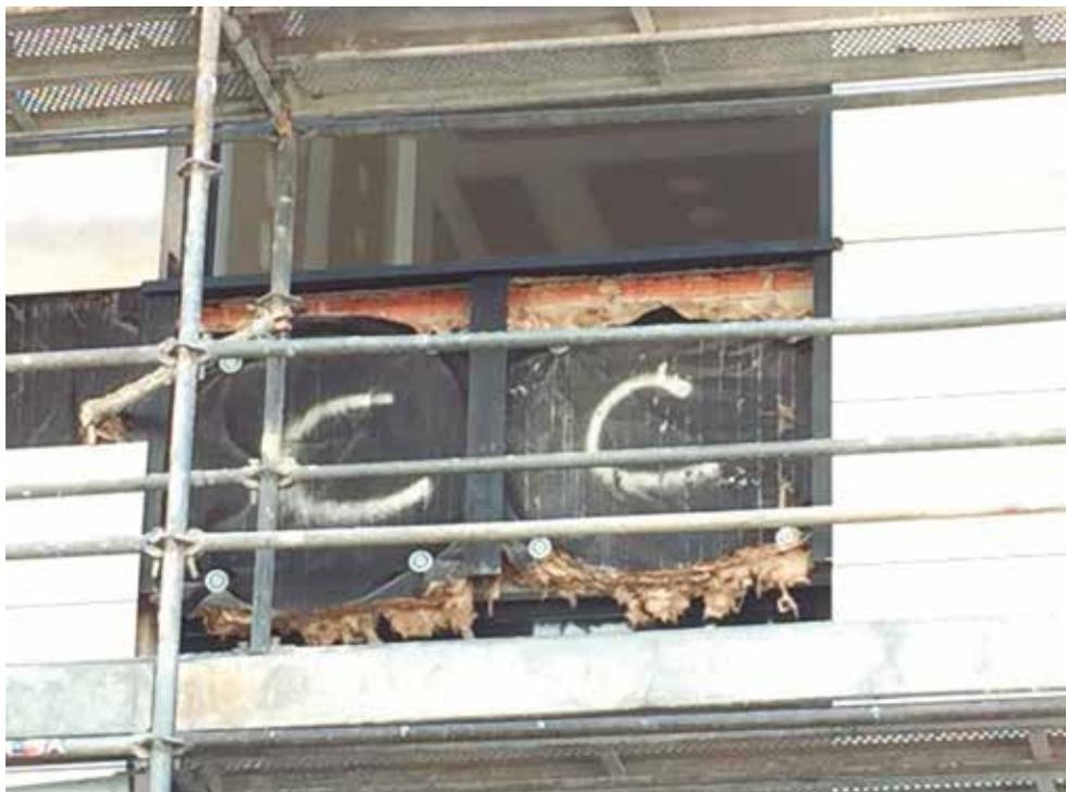
Ejemplo de aislamiento térmico que ha sido correctamente instalado, pero ha sufrido deterioro durante el proceso de construcción y antes de su recubrimiento.
