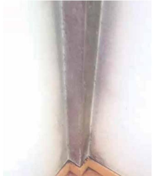
La superficie de la viga se encuentra a menor temperatura que la pared y genera una condensación superficial, que a su vez crea moho. El problema se corrige eliminando este puente térmico con aislamiento.
