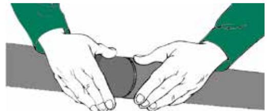
Correcta ejecución de juntas a tope. Se aplica adhesivo en los bordes de ambas coquillas, se juntan los bordes y se presiona firmemente.
